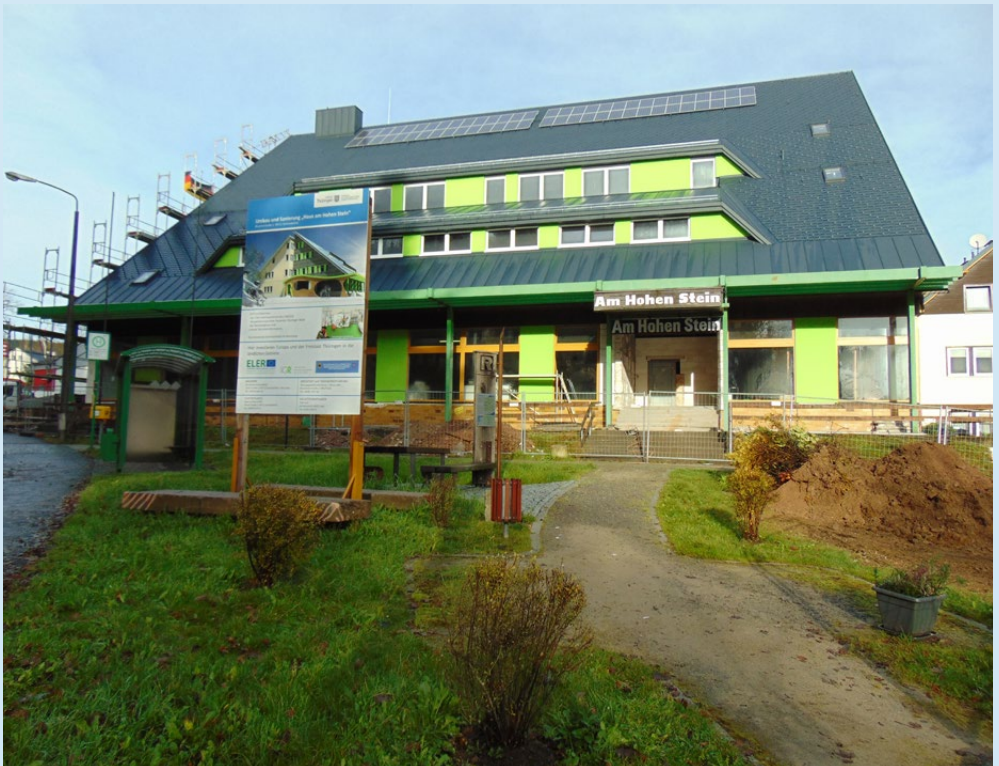
Das im Bau befindliche Informationszentrum in Schmiedefeld am Rennsteig.
